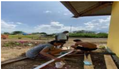
Gambar 8. Pembuatan Papan Nama Jalan
