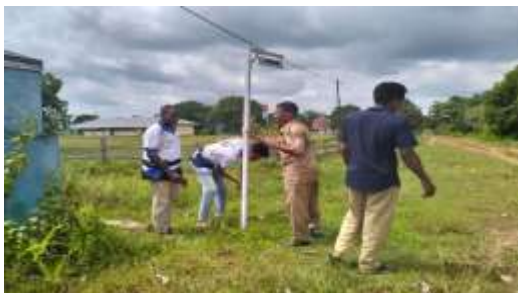
Gambar 9. Pemasangan Papan Nama Jalan
