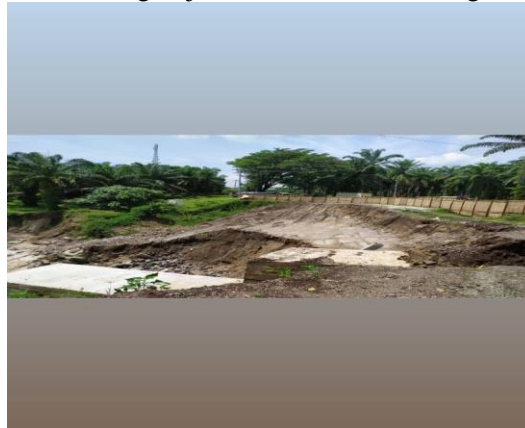
Gambar 1. Lokasi pembangunan turap
