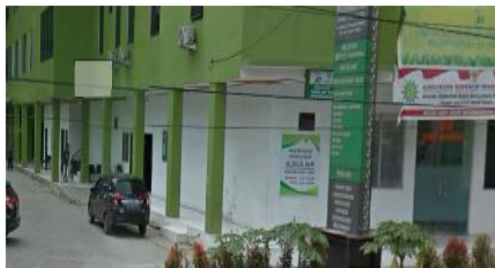
Gambar 9 Kondisi Existing Koridor Luar Bangunan
