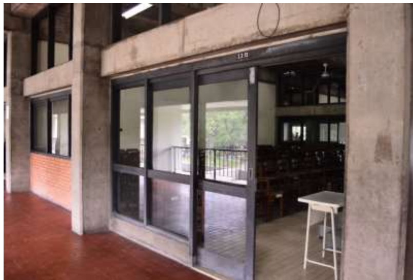
Gambar 5. Pintu, jendela dan kusen Gedung Kuliah HKBP Nommensen
