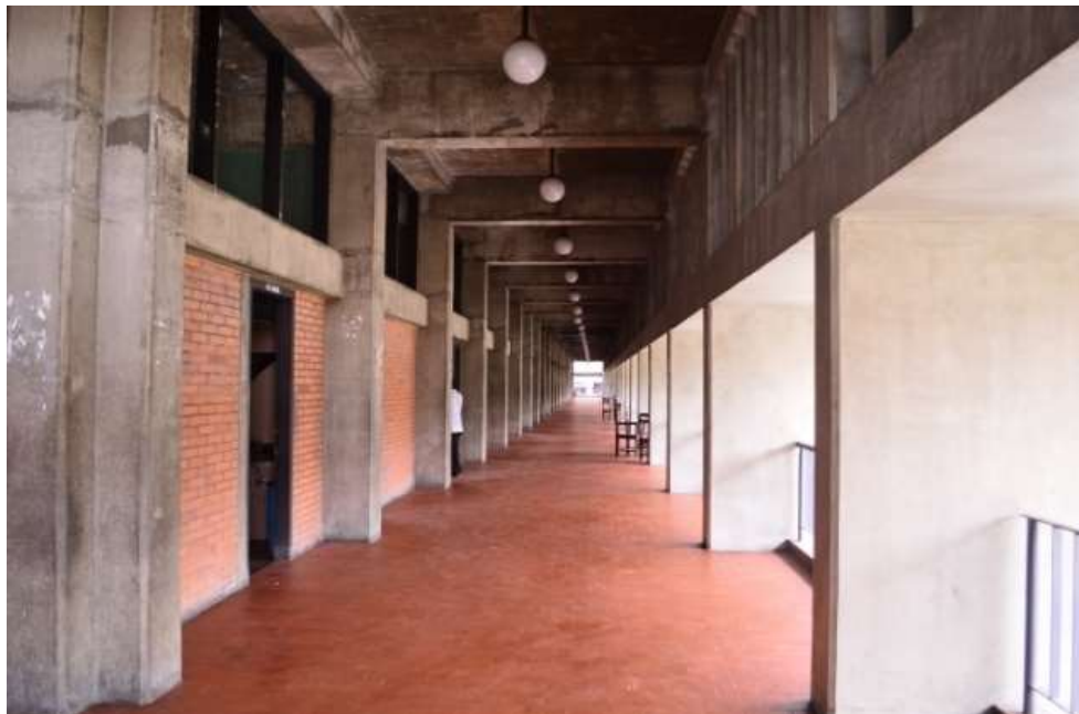
Gambar 4. Dinding Gedung Kuliah HKBP Nommensen
