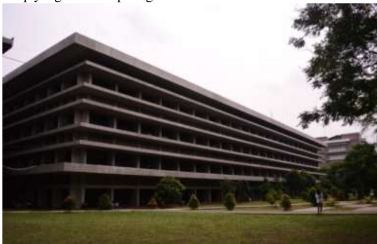
Gambar 2. Atap beton datar Gedung Kuliah HKBP Nommensen
